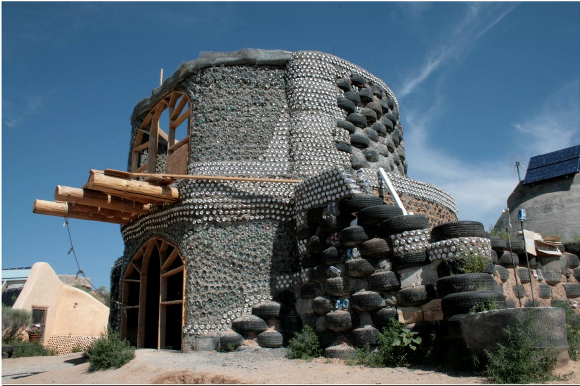
Le pneu est le composant principal des earthships américains, ces habitations sauvages généralement construites en plein désert à base de déchets, avec des bouteilles et des pneus. Certains sont des modèles de constructions bio-climatiques. Les murs en pneus sont remplis de terre et font des murs très stables et isolants, avec une grande inertie thermique.
